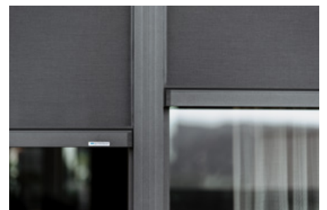
Textile Screens Detailaufnahme
