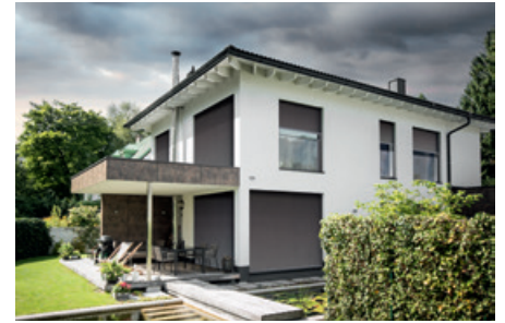
Absturzsicherung kombiniert mit Textil Screen
